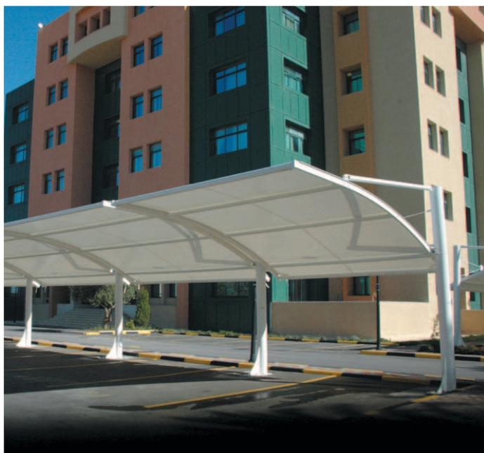
La copertura per auto Parking light è una struttura progettata secondo le norme UNI EN 13782:2006, C.T.S. e D.I.N. 4112, ad uso pubblico e privato.
